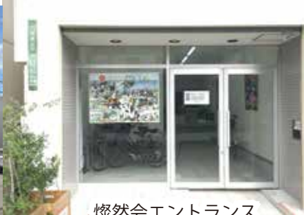
燦然会エントランス
